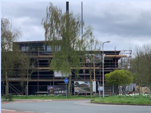
De ramen op zolder zijn geplaatst.
