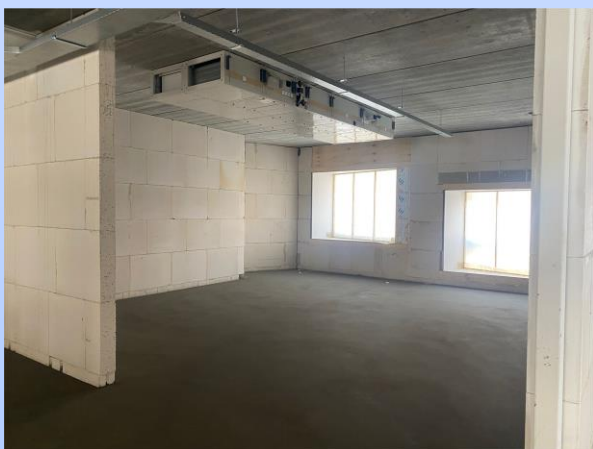
Inkijkje in één van de lokalen van de groepen 1/2. Het luchtsysteem hangt al.
